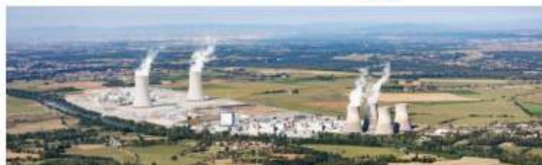
Deux tours aéroréfrigérantes
